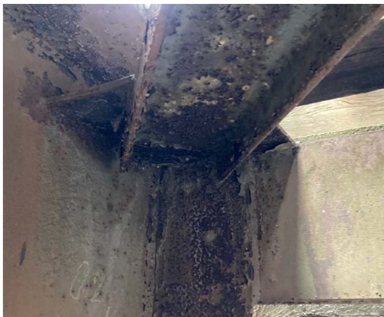
Důlková a plátková koroze a poškození PKO
